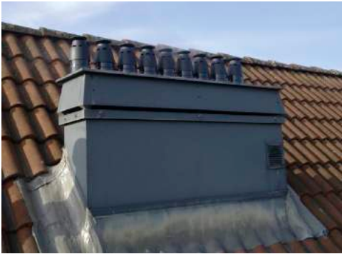
Dakdoorvoeren van individuele RGA
